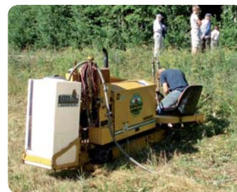
Kuva 34. Vaakaporaamalla tehty tienalitus 12 m
