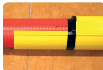
Kuvat 22 ja 23. Vaurioituneen Tripla-putken korjaaminen halkaistulla putkella.
