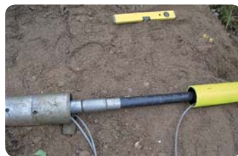
Kuva 29. Tripla-putken kiinnitys myyrään
