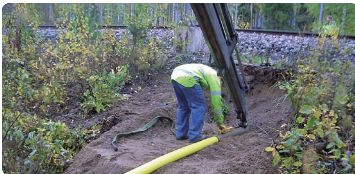
Kuva 31. Tripla-putken rautatien alitus myyrän avulla. Alituksen pituus 15 m
