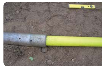
Kuva 30. Tripla-putken kiinnittäminen porauslaitteeseen
