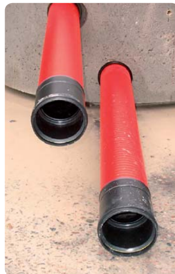
Kuva 19. Triplan läpivienti betonikaivoon
